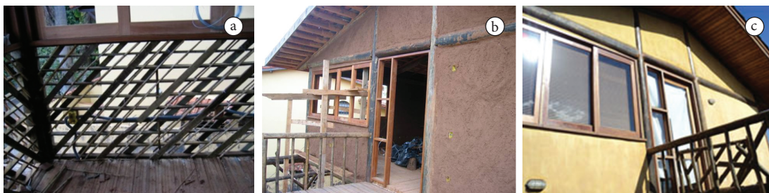
Figura 12. Parede entre os pilares A2 e B2. a) trama em diagonal da taipa de mão; b) execução da meia parede de taipa de mão; c) batente fletido da janela.
