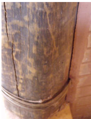
Figura 6. folga entre o pilar e o anel metálico. Figure 6. gap between the column and the metal ring.
