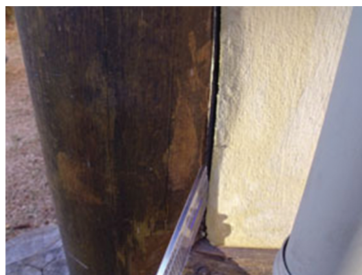
Figura 10. Pilar B9 - a fresta entre o pilar e a vedação mediu 10 mm.
