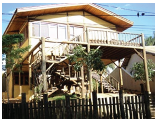
Figura 2. Foto da fachada principal da residência (face oeste) – São Carlos, SP (Foto: autoras, 2011).
