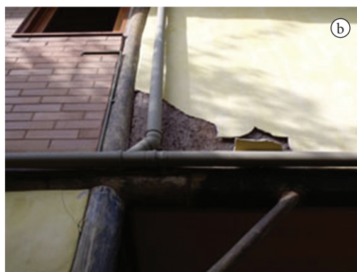
Figura 7. Pilar A4 e parede de taipa de mão. a) Localização em planta; b) Descolamento da argamassa de revestimento da parede de taipa de mão.
