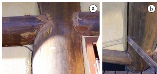
Figura 9. Pilar B8. a) a fresta superior, entre a viga e a vedação, chegou a medir 12 mm; b) a fresta inferior entre o pilar e a vedação mediu 10 mm.
